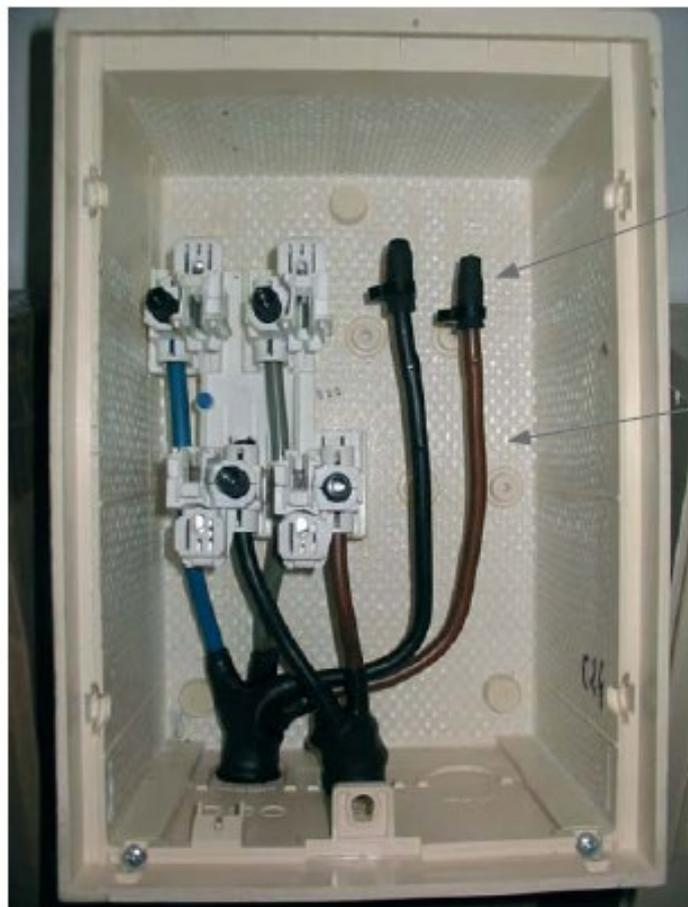
Mise en place de 2 dispositifs d'isolation de phase fournis avec le coffret ou la borne sur les 2 conducteurs laissés en attente
