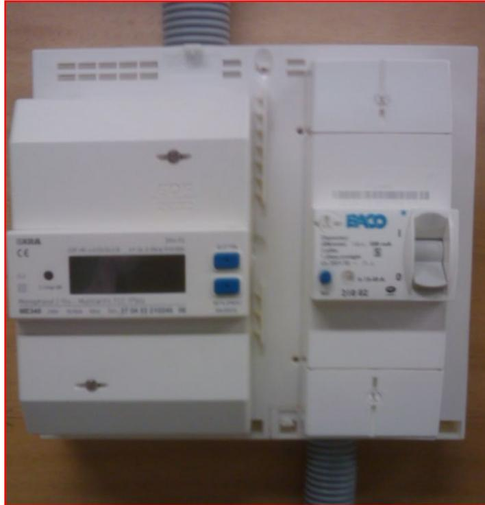
Exemple de montage avec câble arrivée NF C 14-100 par le haut et départ client NF C 15-100 également par le haut. Le panneau est équipé d'un compteur électronique (Linky) et d'un disjoncteur de branchement.
